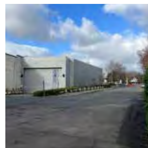
Blinde gevel Carrefour
